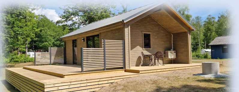
FERIENHAUS S13 NACH DER RENOVIERUNG
