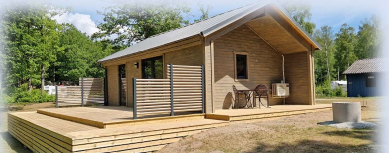
STUGA S13 EFTER RENOVERING
